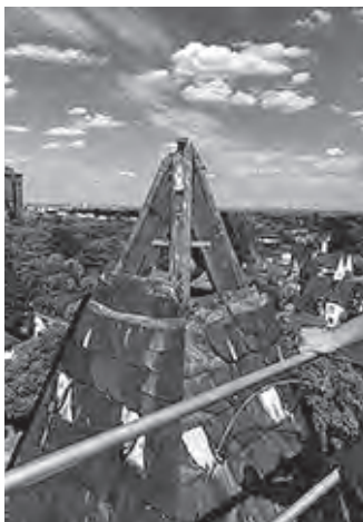
Die Kirchturmspitze nach Abtragung des beschädigten Wetterhahns
